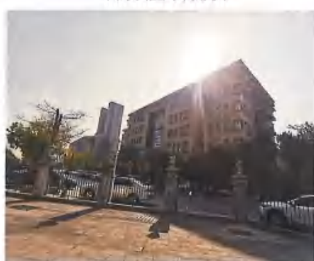
部分屋顶现状
