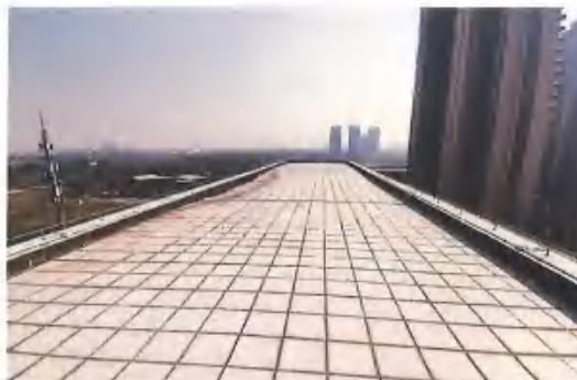
部分屋顶现状
