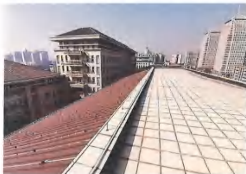
部分屋顶现状
