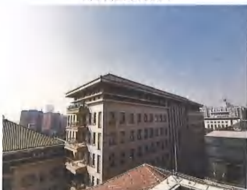
部分屋顶现状
