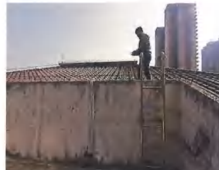
部分屋顶现状
