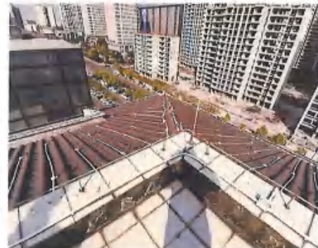
部分屋顶现状
