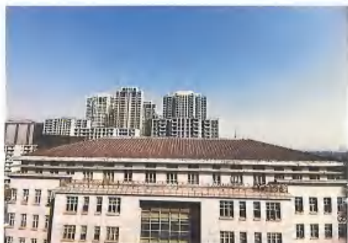
部分屋顶现状
