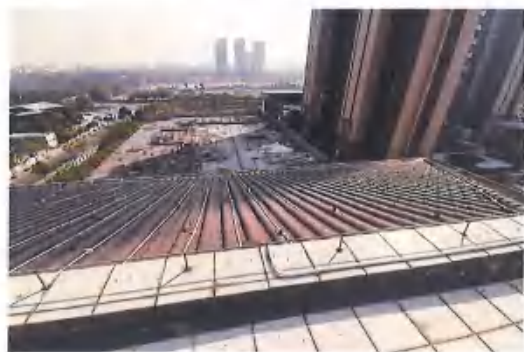
部分屋顶现状
