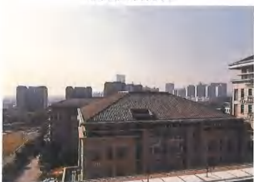
部分屋顶现状
