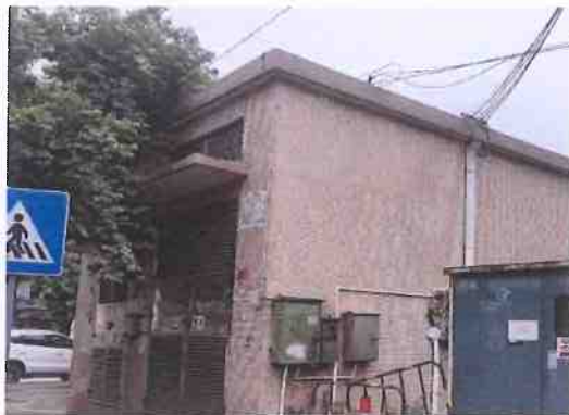
建（构）筑物外观（配电房）
